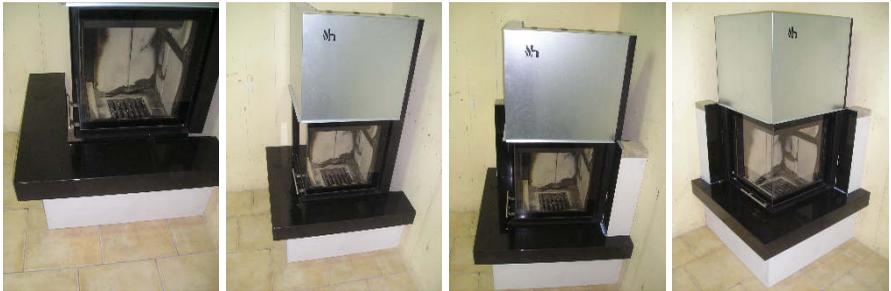
**Punkt 6.** Kleben Sie untere Teil von Isolation bis Wand und festigen Sie alles mit Dübel  $\Phi$  8mm.
