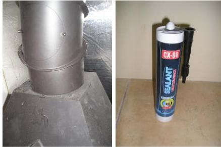
**Punkt 12.** Kleben alles mit ein Kleber zum Wand und Hauben Elemente 5,6 alles noch mit Schrauben ,5x80mm zusammenfesten. Kleben Sie Abdeckung 7 und alle Verbindungen Stärken Sie mit Fassadennetz, welche in dem Kleber eingetaucht ist.
