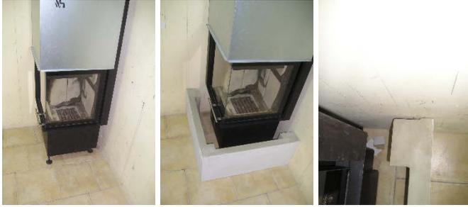
**Punkt 5.** Setzen Sie der Untersims **2** auf dem Sockel. Regulieren Sie Untersims mit Holzkeil beim Boden und Kamineinsatz mit Stellfüßen zum Niveau. Spalt zwischen Untersims und Kamineinsatz soll 2mm haben.
